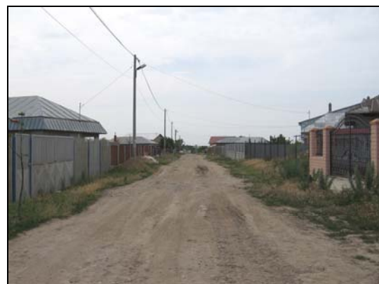
Abbildung 1: Straße in Șendreni innerhalb eines Neubaugebietes
