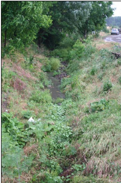
Abbildung 8: Entwässerungsgraben innerhalb einer Ortschaft
