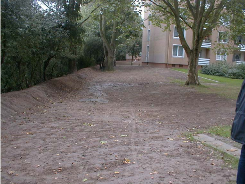
Abbildung 3: Schlammfützen durch falsche Muldengestaltung
