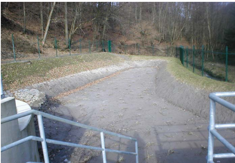
Abbildung 1: Kolmatierter Retentionsbodenfilter
