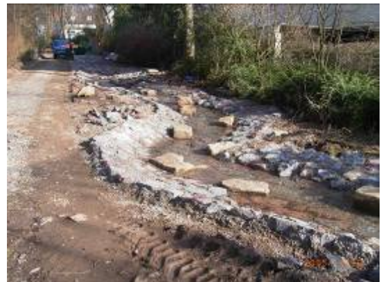
Abbildung 16: Bereits während des Baus floss kristallklares Wasser
