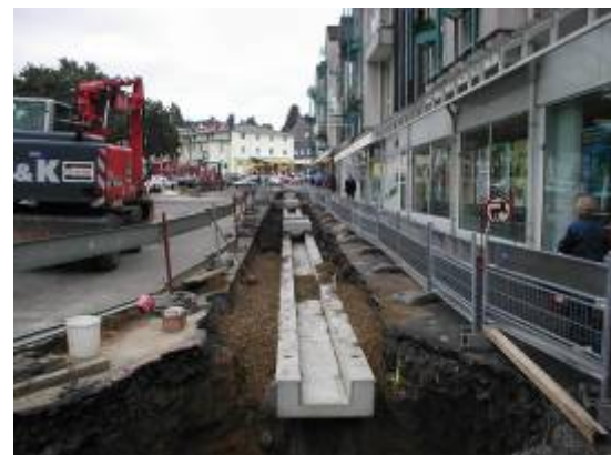
Abbildung 12: Bau der Rinne vor den Geschäften
