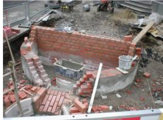
Abbildung 15: Quelle vor den Geschäften im Bau
