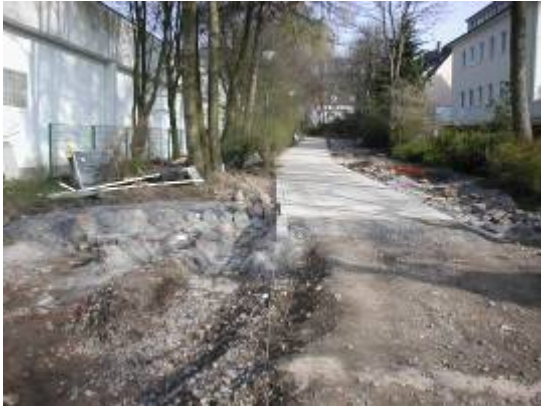
Abbildung 13: Bau der befestigten Rinne im Spielbereich
