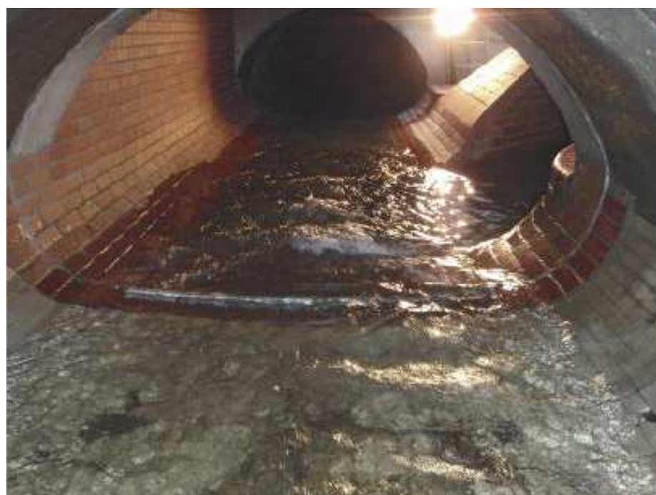
Abb. 2: Querschnitt des kanalisierten Briller Baches im Bereich der Abflussaufteilung
