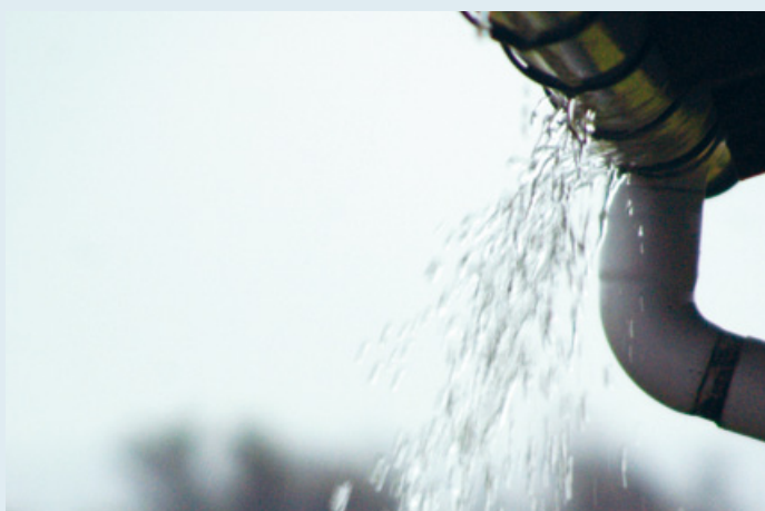
Überströmendes Regenwasser muss von der Oberflächenentwässerung mit aufgenommen werden
